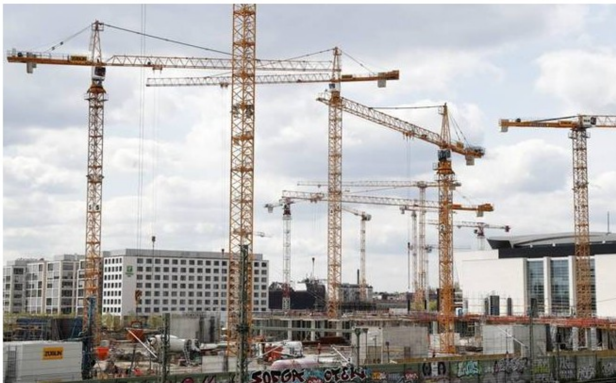
Vista de varias grúas en una zona en construcción. (EFE)
