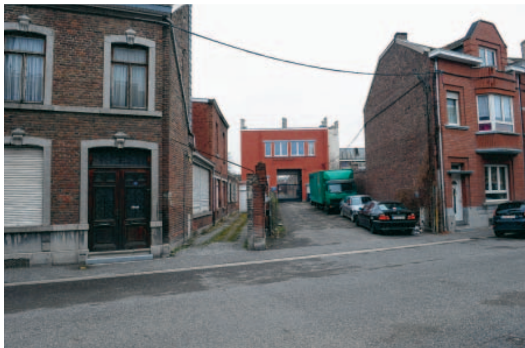
Situé à l'arrière de la route, le futur parking remplacera le bâtiment de Browning.
